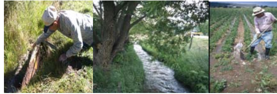
Acequia Vallejos Parshall Flume
